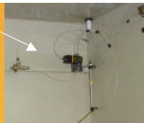
1. Dispositivo de seguridad para la desconexión y descarga automática a tierra.
